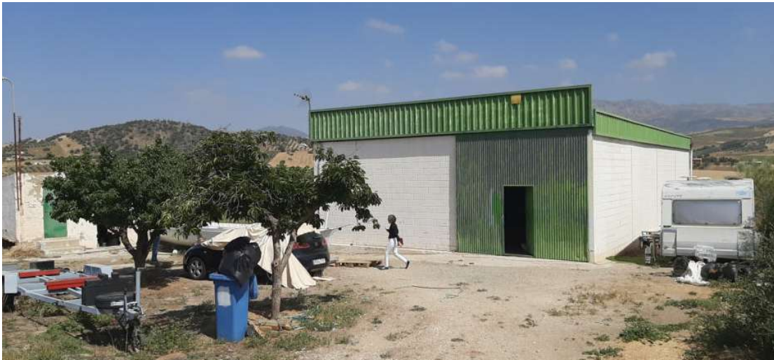
Nave industrial en Arroyo Coche, Almogía – Taller de José Pedro González
